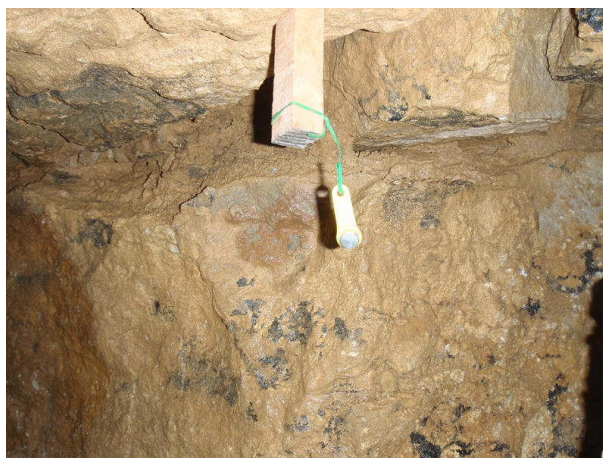
Sonde du fond, à proximité du plafond
